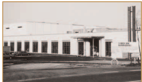
Der Neubau der C.H.Beck'schen Buchdruckerei in Nördlingen, Augsburg Street
